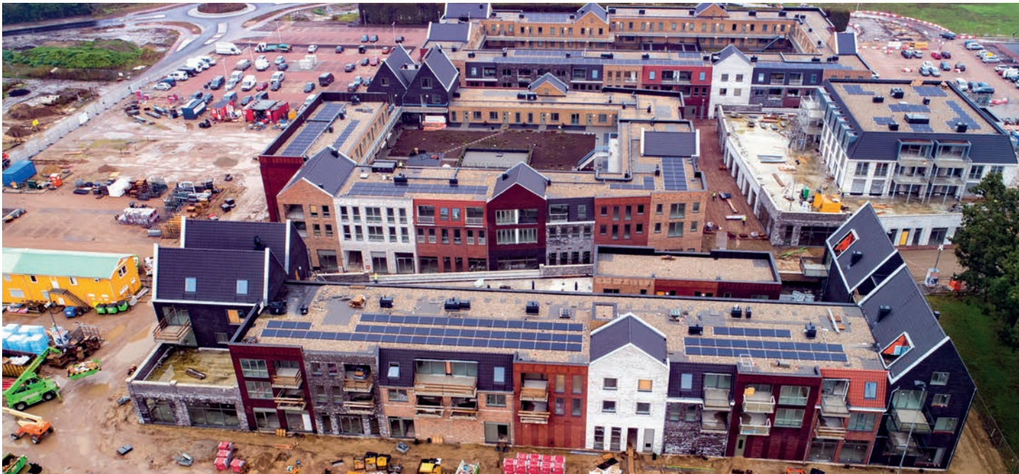
Het project Koningsoord in Berkel-Enschot. Foto: Heijmans
